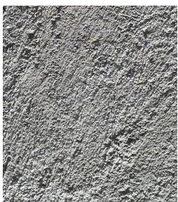
Ejemplo de preacabado rústico: se requiere nivelar y quitar piedras sobresalientes para asegurar una superficie plana y rústica para la aplicación de la pasta original de chukum.
